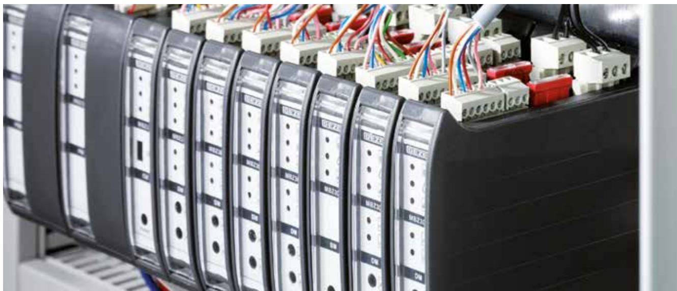
排烟排热机组紧急电源控制单元 总工作电流为 10 A 至 72 A
